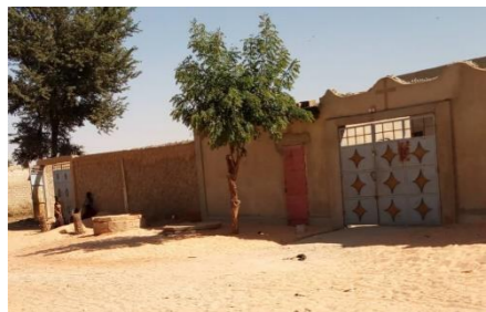
rechts: neue Außenmauer von Pst. Oumarou links anschließend: neu gekauftes Grundstück
